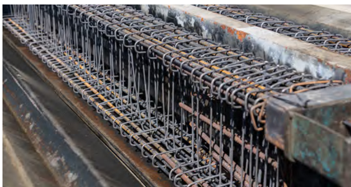
Armação protendida e passiva, densamente estribada.
